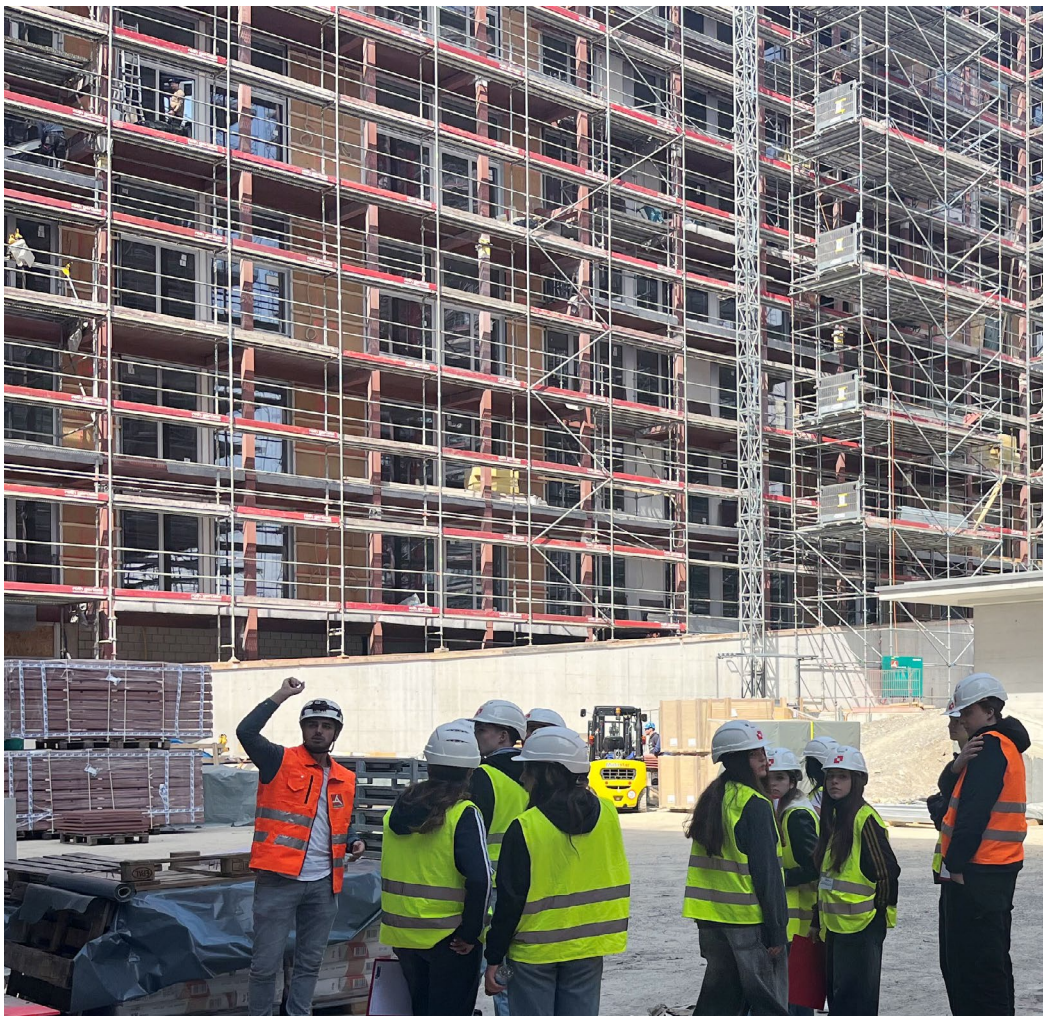
Nouvelle construction, Areal Eichhof Ouest, Lucerne (Classe Lucerne)
